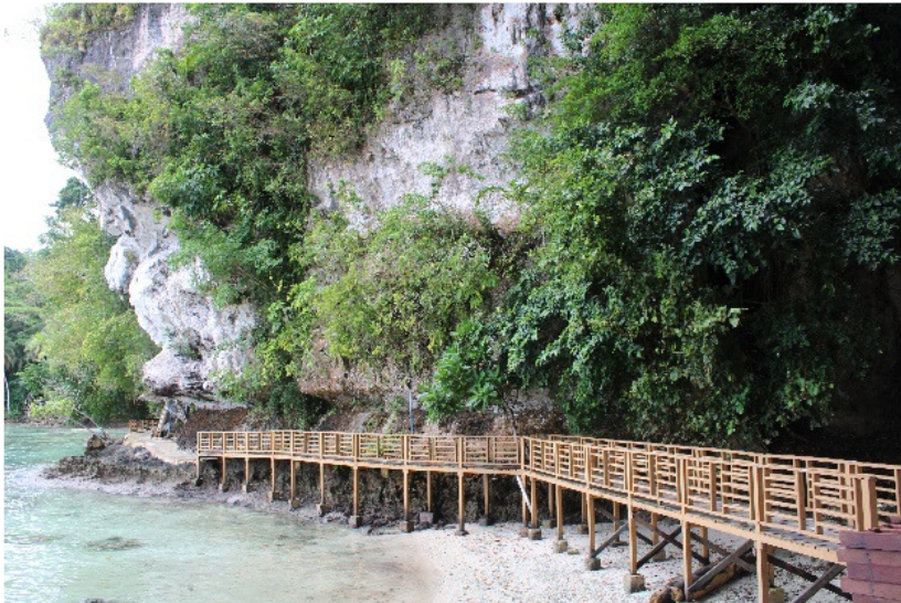
Gambar 9. Jembatan Kayu Sepanjang Dinding Tebing
